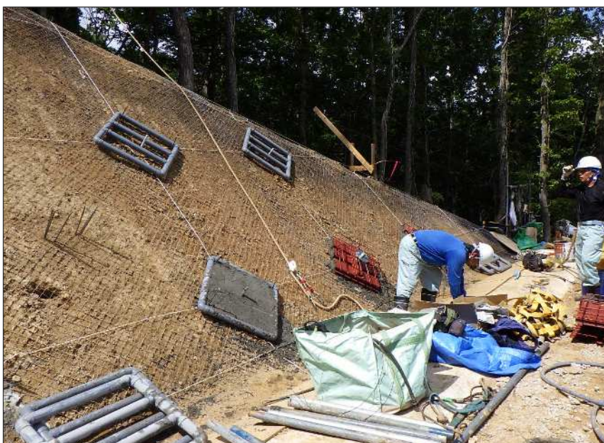
施工状況写真 下地モルタル処理工
