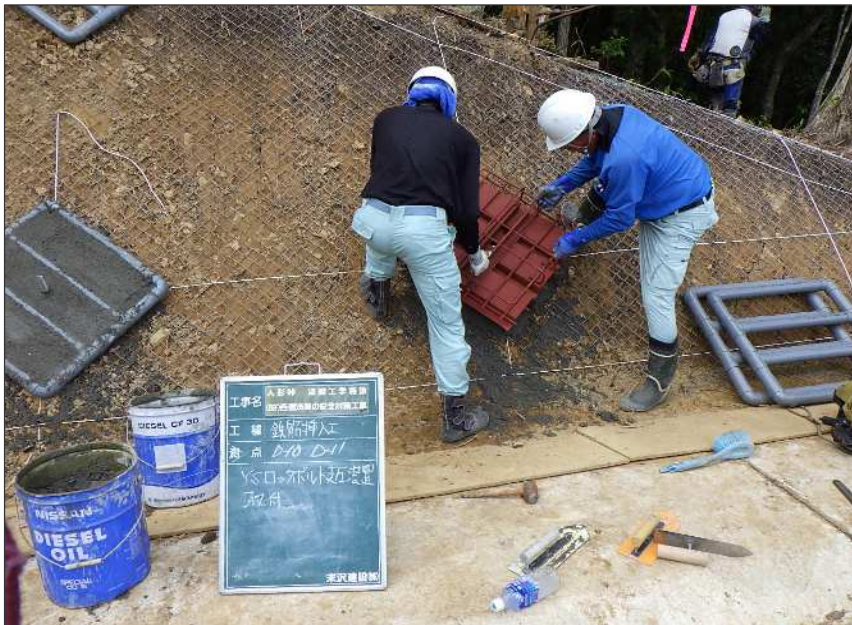
施工状況写真 下地モルタル処理工
