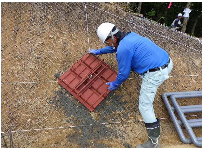
施工状況写真 下地モルタル処理工
