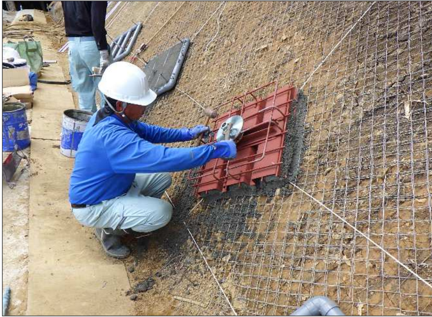
施工状況写真 下地モルタル処理工
