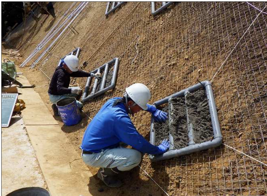
施工状況写真 下地モルタル処理工
