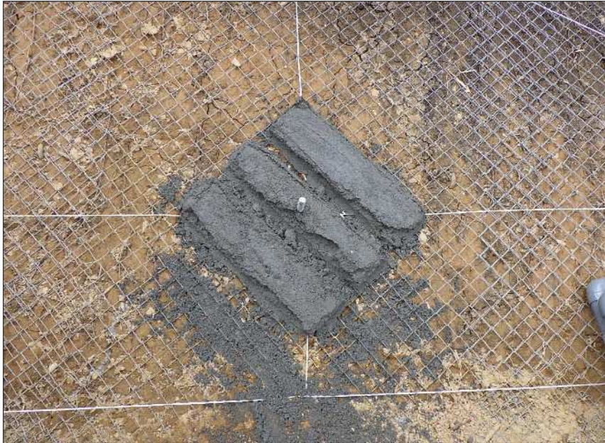
施工状況写真 下地モルタル処理工
