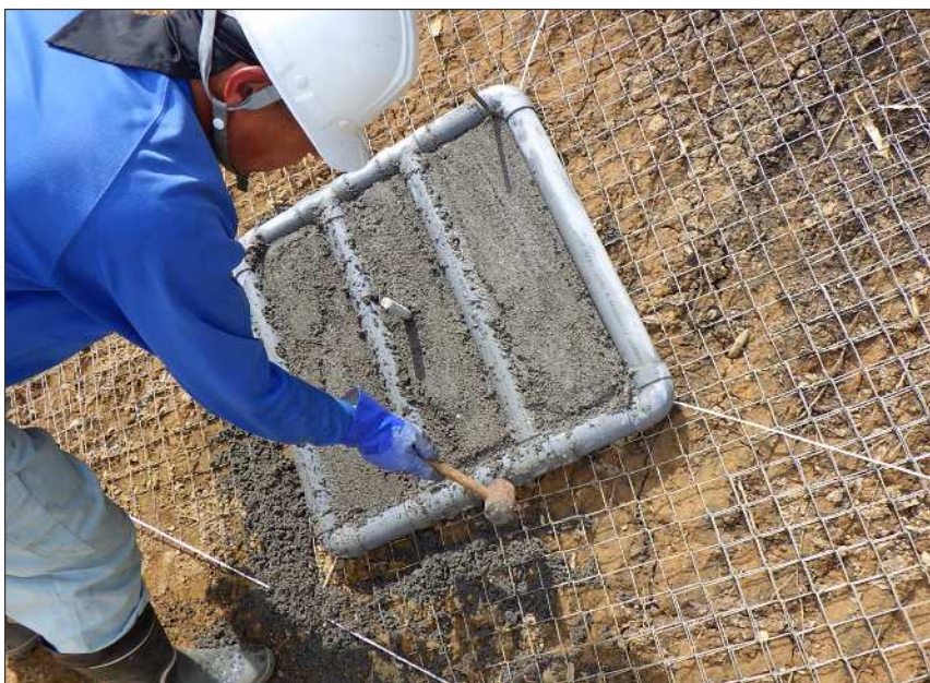
施工状況写真 下地モルタル処理工
