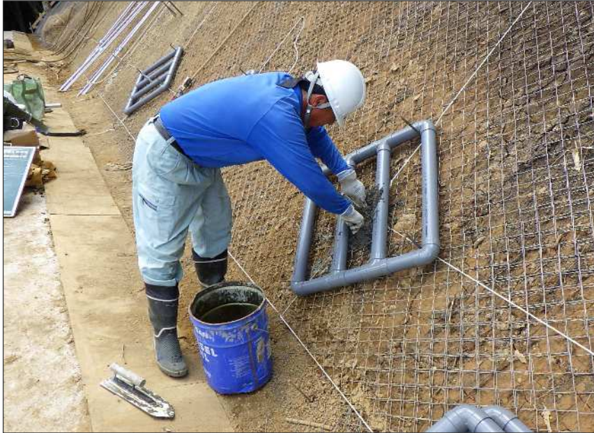
施工状況写真 下地モルタル処理工
