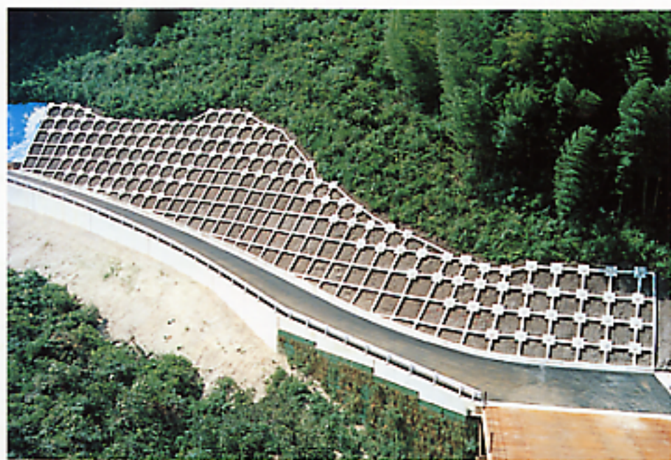
写真-13 支圧板ロックボルト逆巻き工法例
