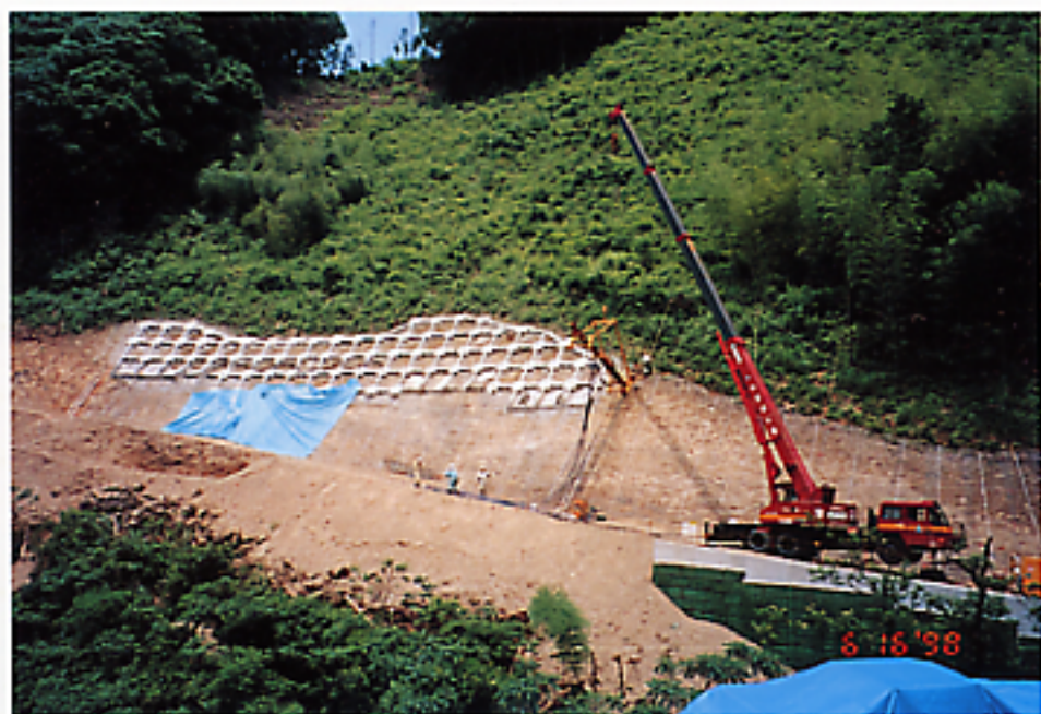
写真-11 支圧板ロックボルト逆巻き工法例
