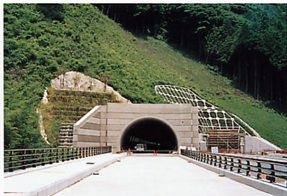
写真-12 支圧板ロックボルト逆巻き工法例
