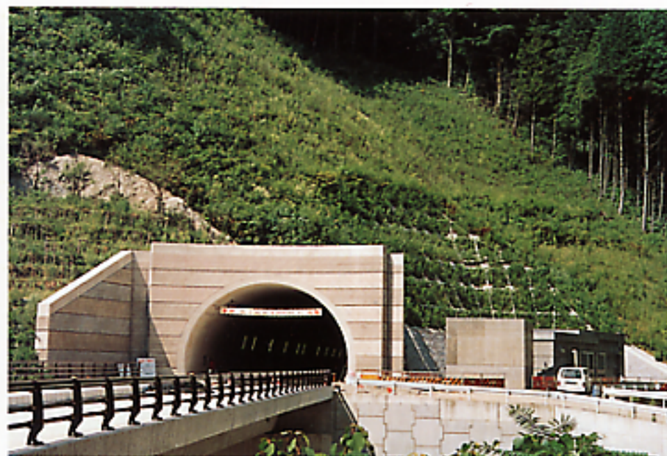
写真-14 支圧板ロックボルト逆巻き工法例
