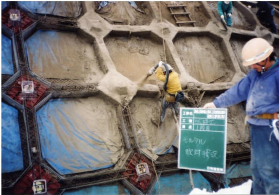
写真5 受圧板部 モルタル吹付状況
