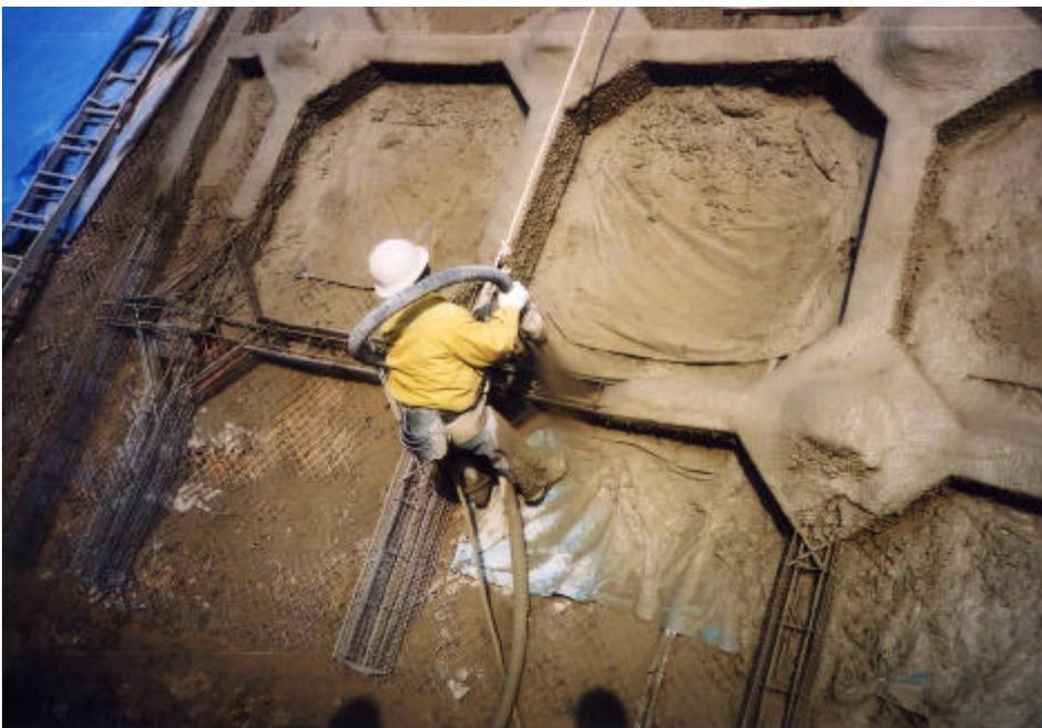
写真4 受圧板部 モルタル吹付状況
